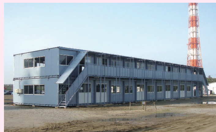
FLEX-H40/現場事務所
