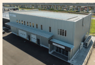
事務所兼倉庫
