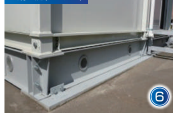
H鋼基礎(レンタル)
